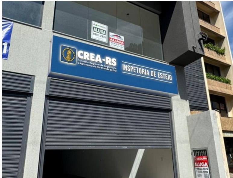
Figura 08 – Imagem ilustrativa esquemática do painel em ACM e letras caixas com retroiluminação a serem fornecidas.
